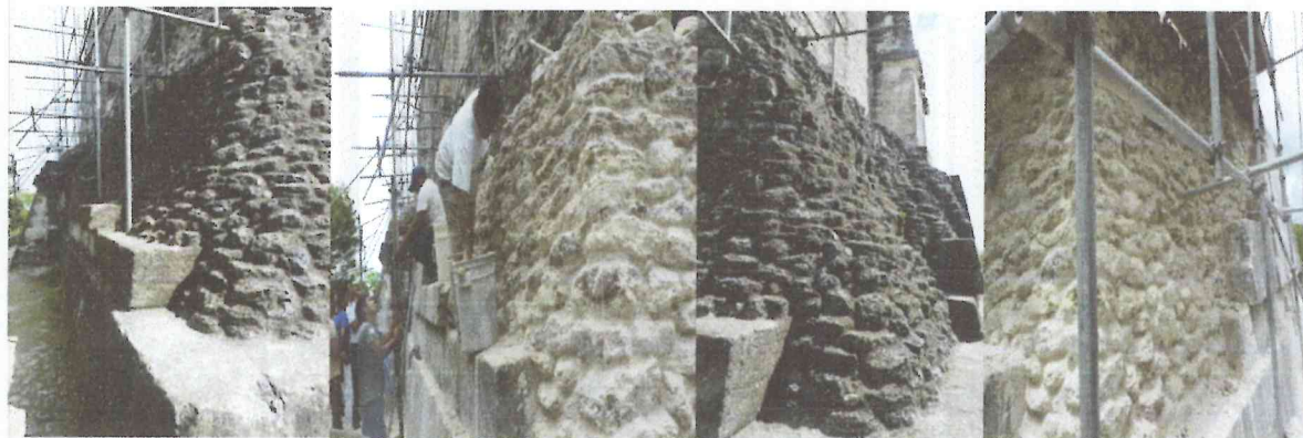
FACHADA OESTE LADO SUR
